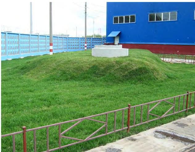
контейнерного терминала на ст. Костариха, в рамках которого территория контейнерной площадки была уложена железобетонными плитами, сооружены система ливневой канализации и резервуар для сбора дождевых и талых вод.
